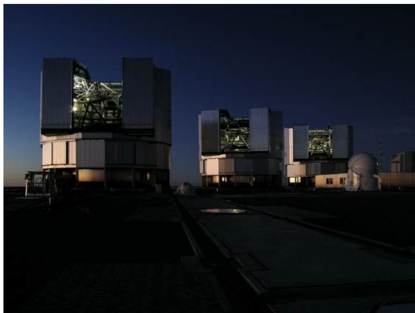
Abbildung 3.3.3: Drei der vier very large telescopes. Jedes hat einen Durchmesser von 8.2 m. Bei Bedarf kann man sie „zusammenschalten“ und somit ein 100 m Teleskop simulieren (Interferometrie)
