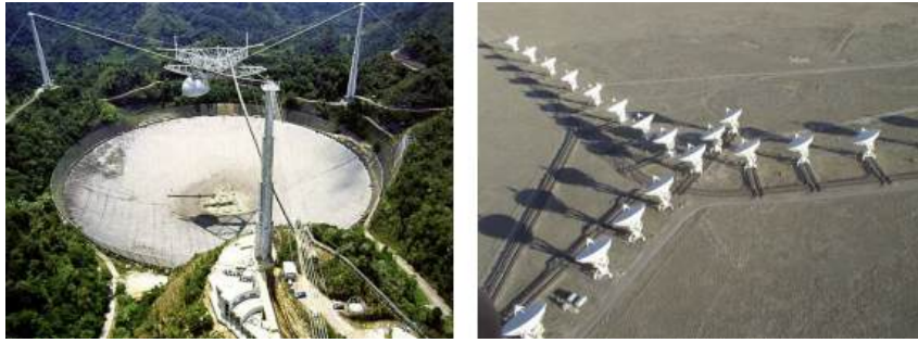
Abbildung 3.4.2: Links: Das William-E.-Gordon-Teleskop in der Nähe von Arecibo. Es war immer zum Zenith hin gerichtet. Rechts: Das Very Large Array in New Mexiko. Viele einzelne Teleskope sind zusammenschaltet (Interferometrie)
